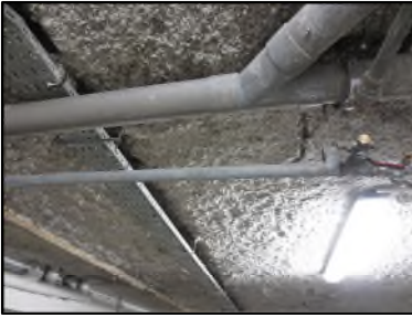
Photo N° 584 ECH-N°1 FLOCAGE -- PARKING Plafonds BLANC COTONNEUX
